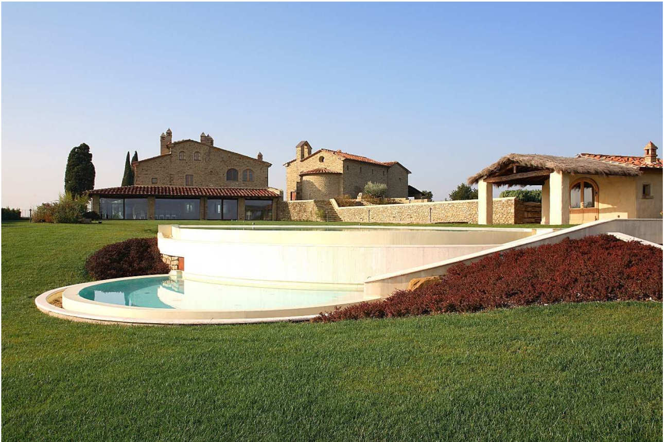
Casa privata - realizzata
