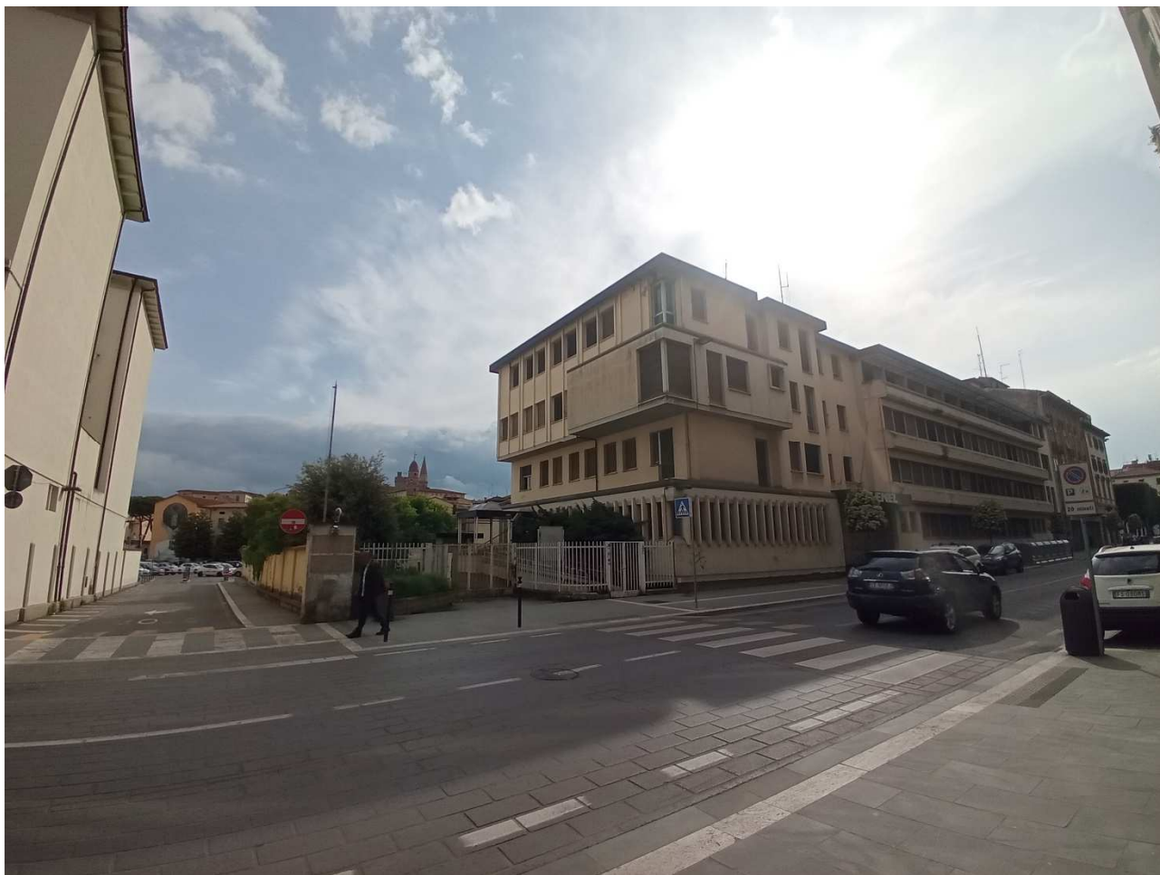
Demolizione e ricostruzione di palazzo (ex Enel) nel centro storico di Arezzo per uno sviluppo di circa 5000mq. da adibire ad appartamenti di civile abitazione
